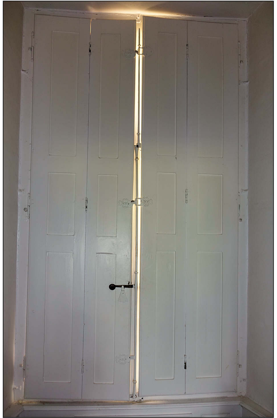
Fig. 5.2. Logis / façade est
